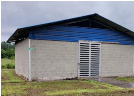
Imagen 1. Centro de Acopio de Residuos
